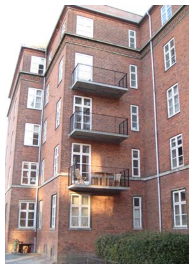
Ovenover ses 3 nye altaner på gadefacade placeret med respekt for facadens murværksdetaljer. Til venstre ses den indstøbte betonbund med fine profileringer i bunden. Steenstrup Allé 13-17/Rosenørns Allé 27A.
