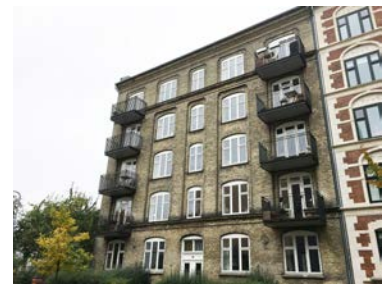
Kong Georgs Vej 6A. Gesimsbånd på 1. og 4. sal er bevaret mest muligt, ved isætning af 1-fags altandør.
