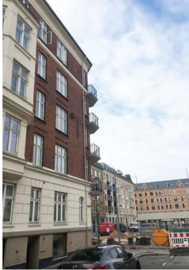
Hjørnealtaner som nyt facademotiv, der bærer henvisning til facadens eksisterende karnapper. Langelands Plads.
