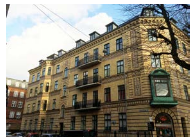
Frederiksberg Allé 12-14. Altanerne tilfører et nyt, varigt præg på en ejendom med høj bevaringsværdi.
